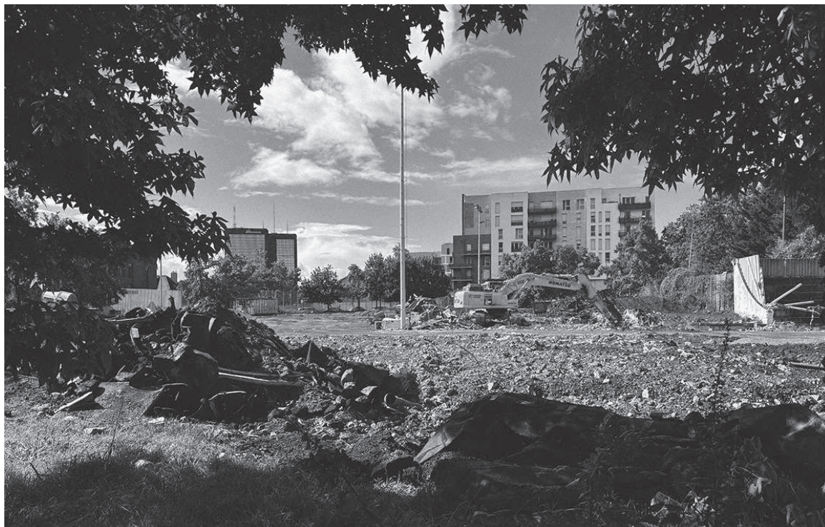
Zone en cours de démolition-reconstruction sur les hauteurs de Bagnolet.
